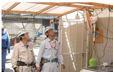
屋内(休憩所)(熱暑対策)
