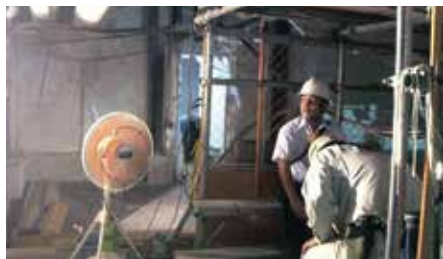
屋内(休憩所)(熱暑対策)
